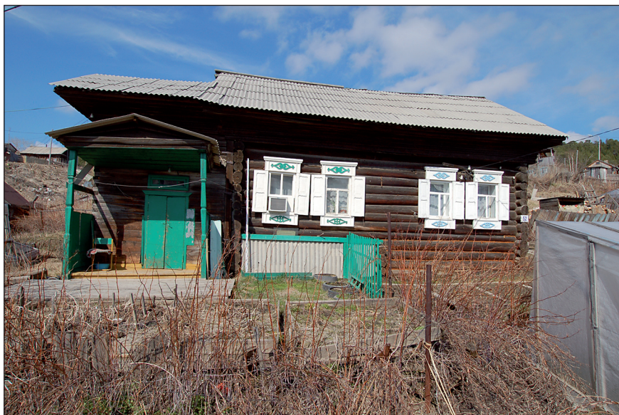
Ил. 1. Жилой дом (г. Ханты-Мансийск, ул. Кирова, 52). Главный (южный) фасад. 2007 г. Фото автора
