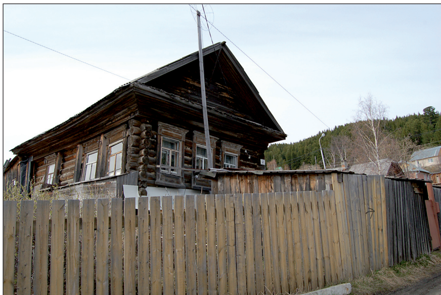
Ил. 7. Жилой дом (г. Ханты-Мансийск, ул. Горького, 17). Общий вид с юга. 2007 г. Фото автора
