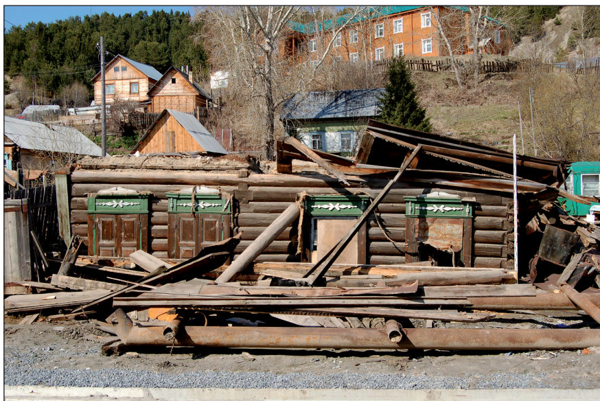
Ил. 6. Жилой дом (г. Ханты-Мансийск, ул. Кирова, 32). Главный (южный) фасад. 2007 г. Фото автора
