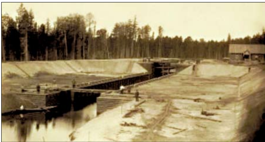
Ил. 12. Обь-Енисейский водный путь. Двухкамерный шлюз на 155-й версте (жилой стан Безымянный). 1910 г. Из кн.: Осипов А.Н. Последний караван Обь-Енисейского канала. – Новосибирск: Ареал, 2013. – С. 13
