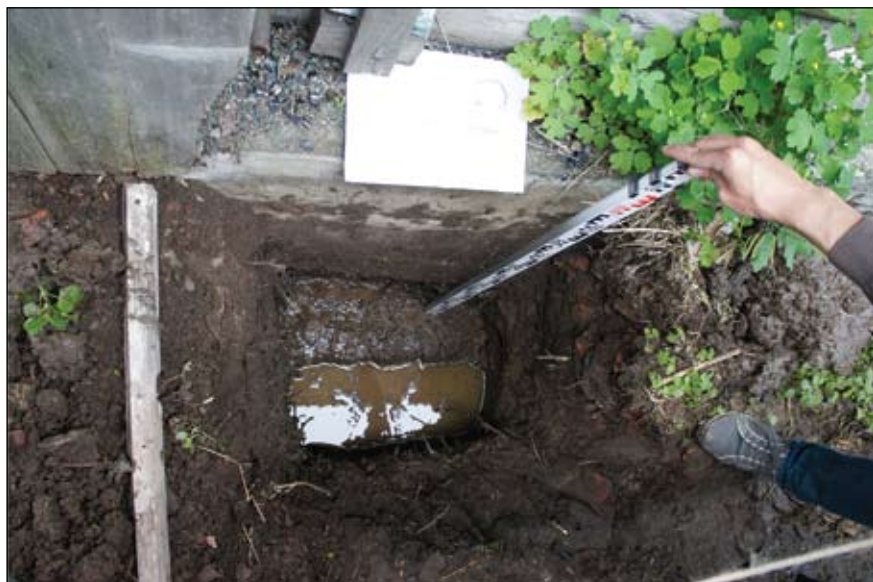
Ил. 27. Жилой дом (г. Ханты-Мансийск, ул. Кирова, д. 22). Восточный фасад. Шурф до кладки цоколя. 2014 г. Фото: Г.И. Мониц
