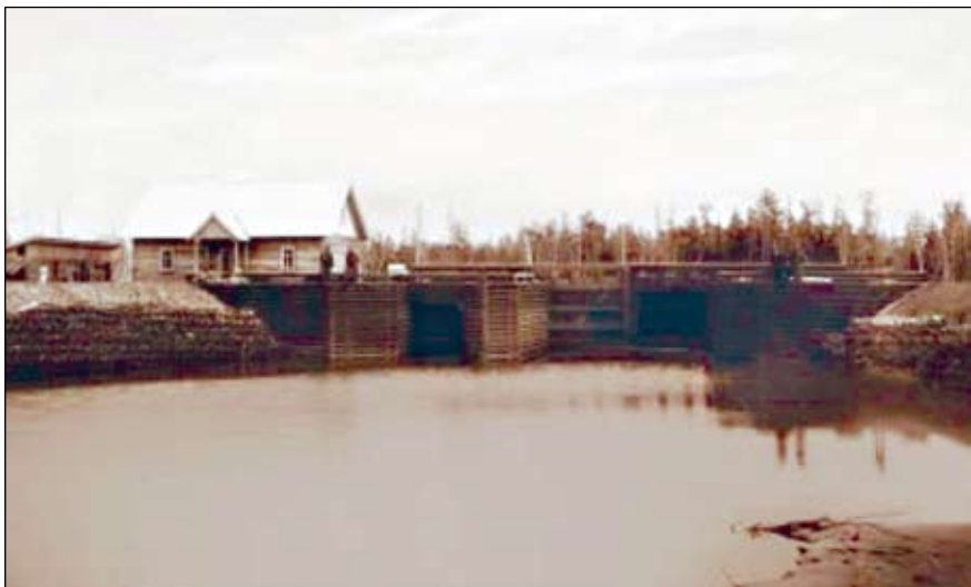
Ил 8. Обь-Енисейский водный путь. Шлюзо-плотина и сторожевой дом на 72-й версте (жилой стан Генеральский). 1910 г. Из кн.: Осипов А.Н. Последний караван Обь-Енисейского канала. – Новосибирск: Ареал, 2013. – С. 15
