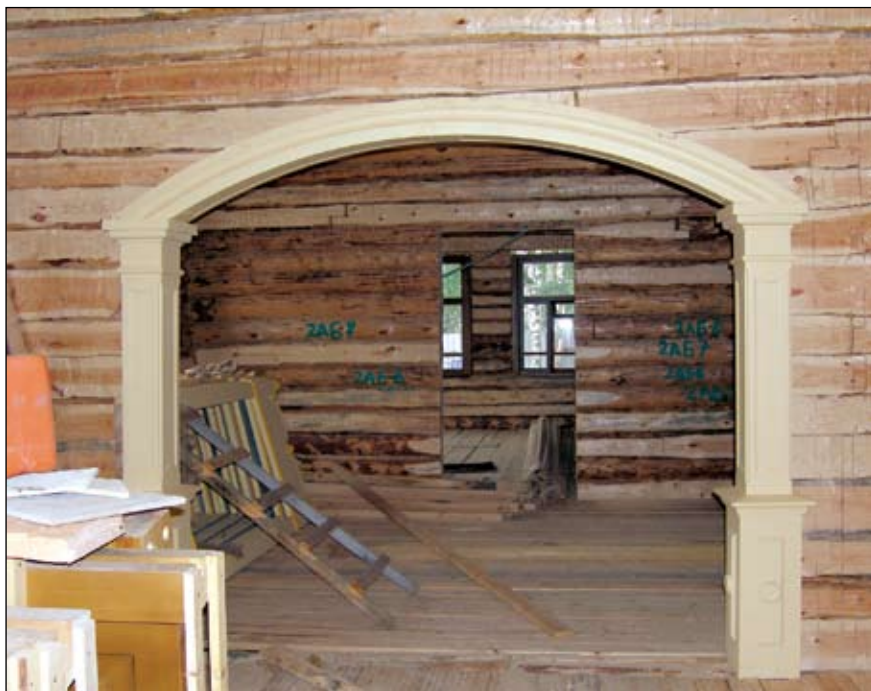
Ил. 3. Объект культурного наследия «Дом купца Добровольского К.И.» (п. Берёзово). Реставрация интерьеров. 2014 г. Фото: Я.А. Яковлев
