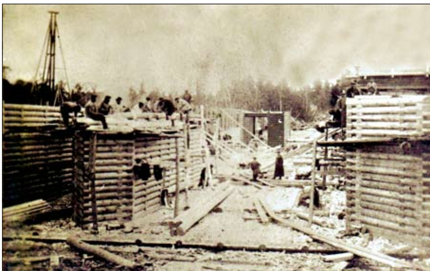
Ил. 7. Обь-Енисейский водный путь. Окончание нарубки надводной части шлюзо-плотины на 72-й версте (жилой стан Генеральский). 1887 г. Из личного архива Г.М. Залесова (г. Томск)
