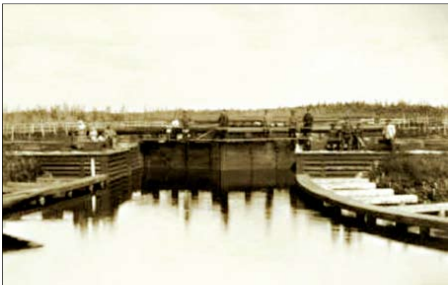
Ил. 11. Обь-Енисейский водный путь. Верхняя часть шлюза на 103-й версте (жилой стан Касовский). 1895 г. Из кн.: Осипов А.Н. Последний караван Обь-Енисейского канала. – Новосибирск: Ареал, 2013. – С. 13
