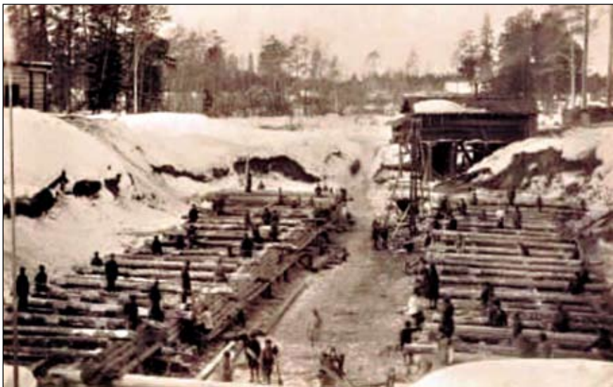
Ил. 3. Обь-Енисейский водный путь. Нарубка береговых устоев шлюза на 15-й версте (жилой стан Ломоватый). 1887 г. Из кн.: Осипов А.Н. Последний караван Обь-Енисейского канала. – Новосибирск: Арал, 2013. – С. 11
