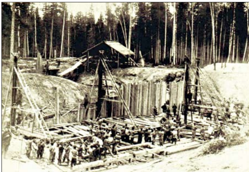
Ил. 15. Обь-Енисейский водный путь. Строительство основания шлюза на 103-й версте (жилой стан Касовский). Забивка свай ручными копрами. Из личного архива Г.М. Залесова (г. Томск)
