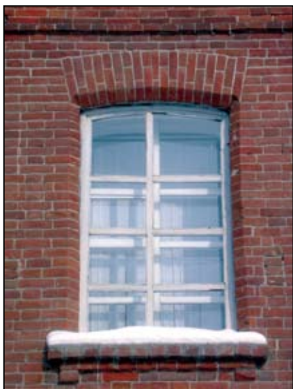
Ил. 16. Берёзовская начальная общеобразовательная школа. Оконный проём. 2008. Фото: А.Н. Кондрашёв
