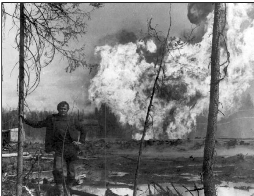
Ил. 5. Авария на первой буровой на Варьёганском месторождении. 1974 г. Экспозиция музея ОАО «Варьёганнефть»
