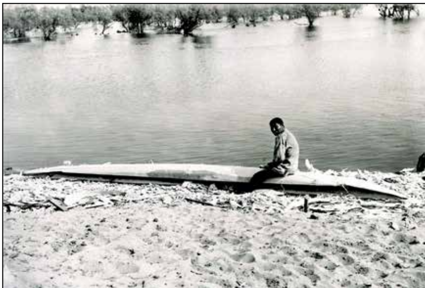
Авторская подпись Г.М. Дмитриева-Садовникова на фотографии, подготовленной к его статье «Ваховский облас»: «Остругивание стругом поверхности обласа». Юрты Ларьякские. 1913 г.
