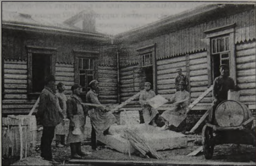
Строительство Парабельской больницы. Ок. 1929-1930 гг. Фото Шапиро. Из домашнего архива Д.Д. Донского.
