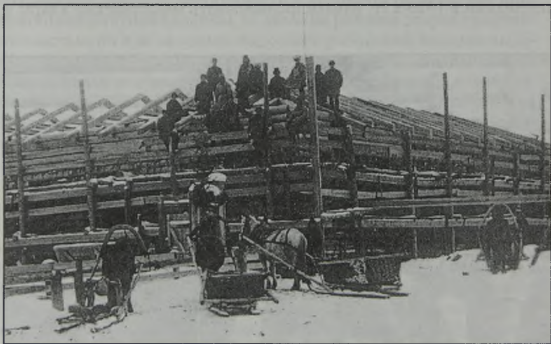
Строительство нового стационара больницы в Парабели. Ок. 1929-1930 гг. Из домашнего архива Д.Д. Донского.
