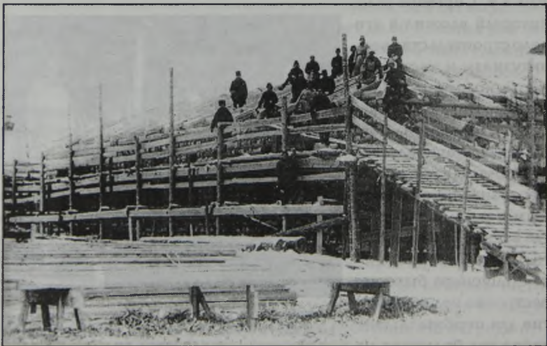
Строительство Парабельской больницы. Ок. 1929-1930 гг.
